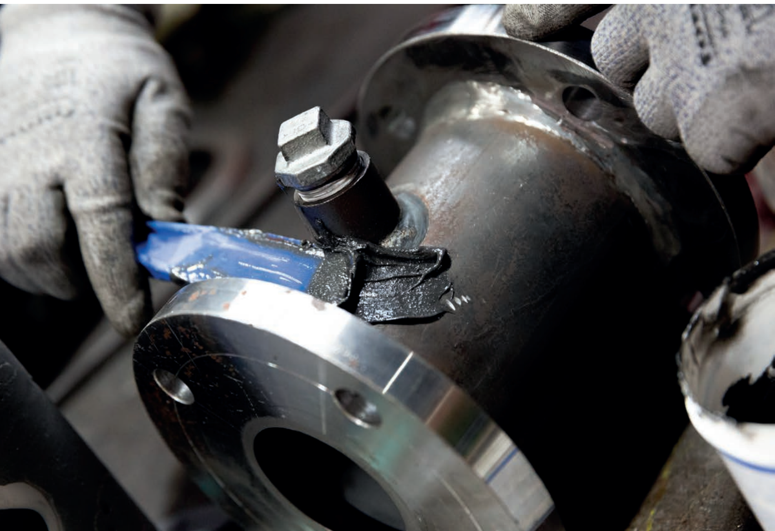
Kuluneen putken korjaus Weicon SF terästyhteisellä keinometallilla.
