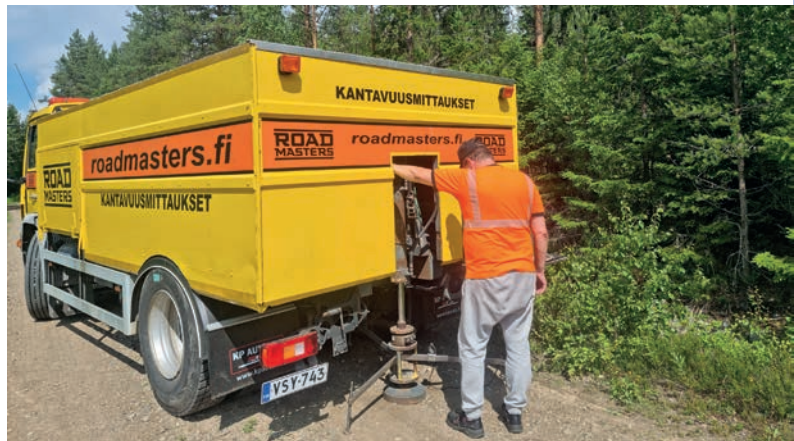
Levykuormituskokeita tuulipuiston tiestöllä.
