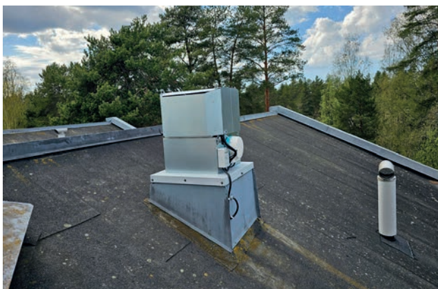
Entos TopAir OG -huippuimurin asennus on valmis.
